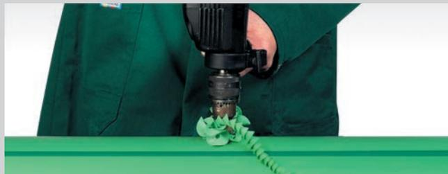
Сверление отверстия в стенке трубы
