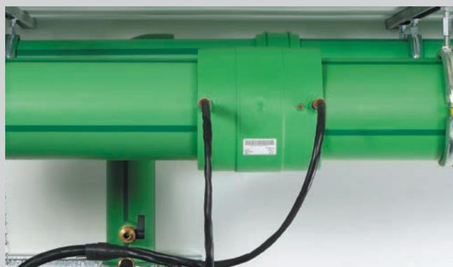
Сварочный аппарат настроить на диаметр муфты. Начать процесс сварки. Выдержать время охлаждения. Готово!
