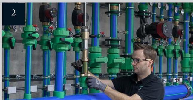
Установка сверильного инструмента на блок наварного седла
