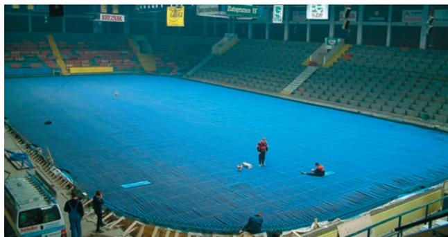
Распределительные трубы, а также распределительные подсоединения изготавливаются из устойчивых к коррозии пластмассовых труб, подключенных по принципу Тихельмана (Tichelmann-Prinzip). Для создания распределительных отводов используется разработанная фирмой aquatherm технология сварных сёдел, экономящая время монтажа.
