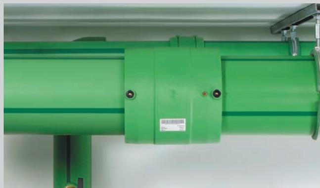
Насаживание второй, очищенной и зачищенной, трубы в муфту
